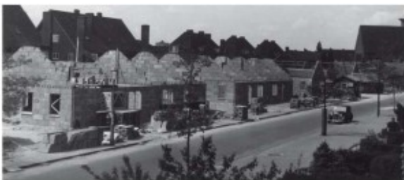
Woningbouw in 's-Hertogenbosch
