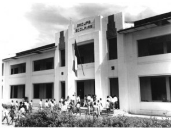
The Groupe Scolaire Building in Coquilhatville
