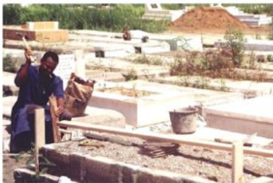
„afbeelding 7.2: Metselen van een 'kelder', rk-begraafplaats (Louis Noorlander)“
