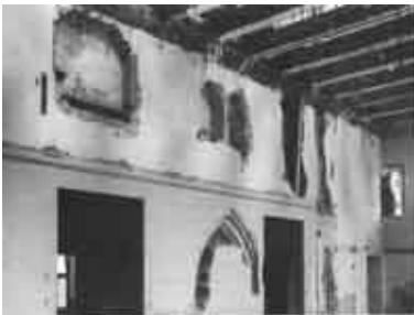
Afb.20. Het noorderlijke deel van de westmuur van het dormtergebouw. Onder de resten van twee spitsbogen. Middenboven het dubbele wasbekken. Rechtsboven de 'nachtdeur' naar de kerk. Foto: G.J. Lauwers
