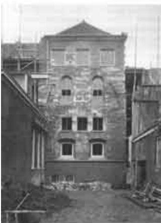
Afb.8. De zuidelijke transeptgevel van de abdijkerk in de Hofpoort in 1955 na de restauratie. Foto: G.J. Lauwer, HUA TA La 9.48. Rechts moet de nieuwbouw nog
