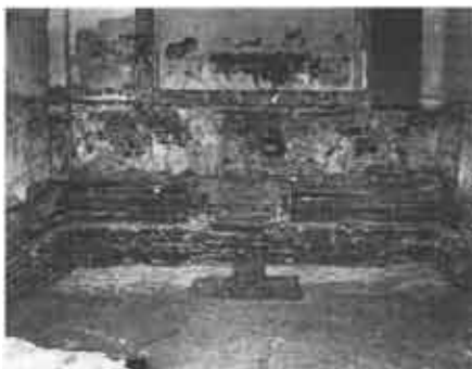
Afb.14. Het fundament van de zuidelijke transeptmuur.
