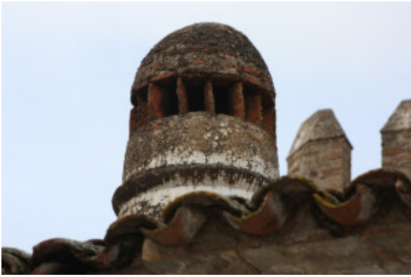
La chimenea más antigua del pueblo The oldest chimney of the village
