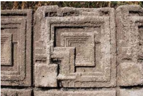
Los Angeles, Ennis House, Detail van de "textile blocks" ontworpen door Frank Lloyd Wright in 1924
