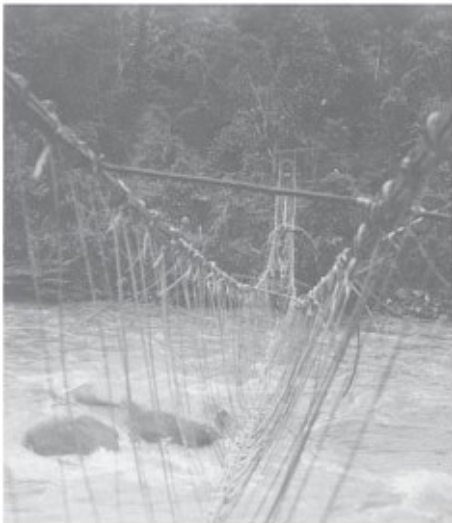
Rotanhangbrug over de Digoel rivier (Ok Tsjiap)
