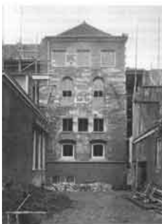
Afb.8. De zuidelijke transeptgevel van de abdijkerk in de Hofpoort in 1955 na de restauratie. Foto: G.J. Lauwer, HUA TA La 9.48. Rechts moet de nieuwbouw nog
