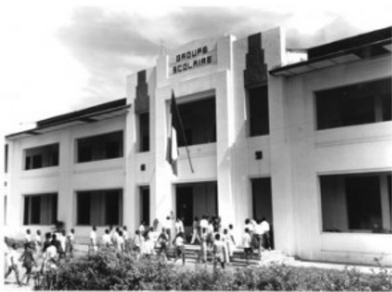
The Groupe Scolaire Building in Coquilhatville
